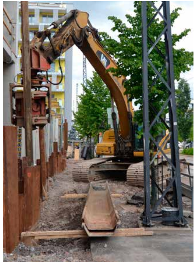
Kaivinkone, joka on varustettu Movax-pontiniskijälä. Kuvassa ponttien nostaminen.
